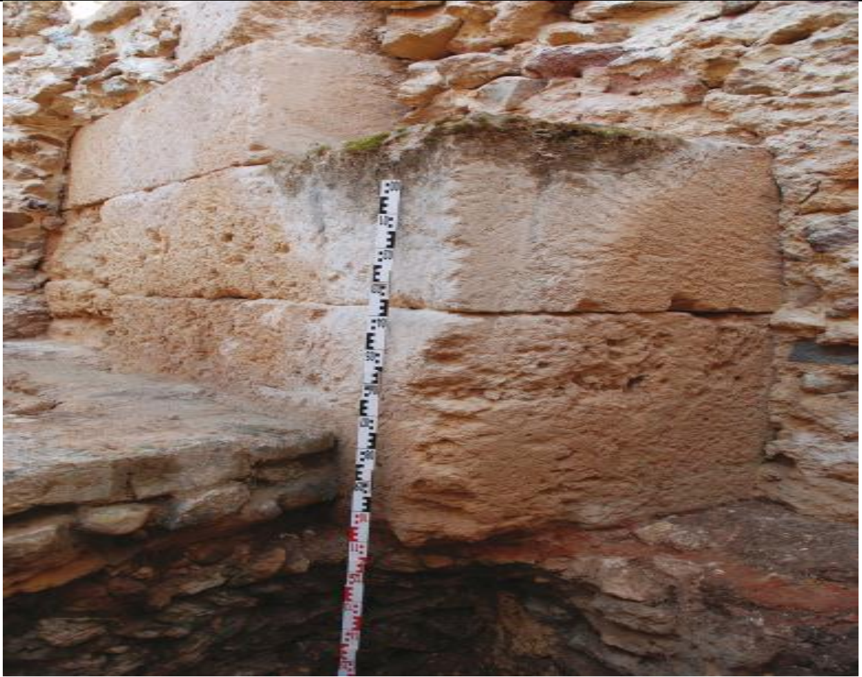
Fig. 12 : Carthage, Rue Ibn Chabâat, Mur oriental de l'édifice I sur fondations de la période punique ancienne de la salle T2.
