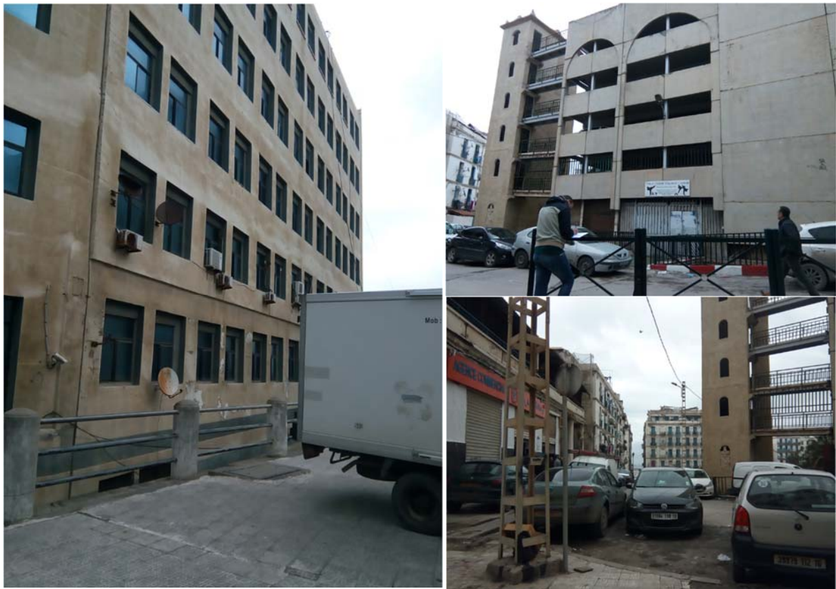
Figure 104: Point 10 Le Parking. Source : Auteure 2018.
