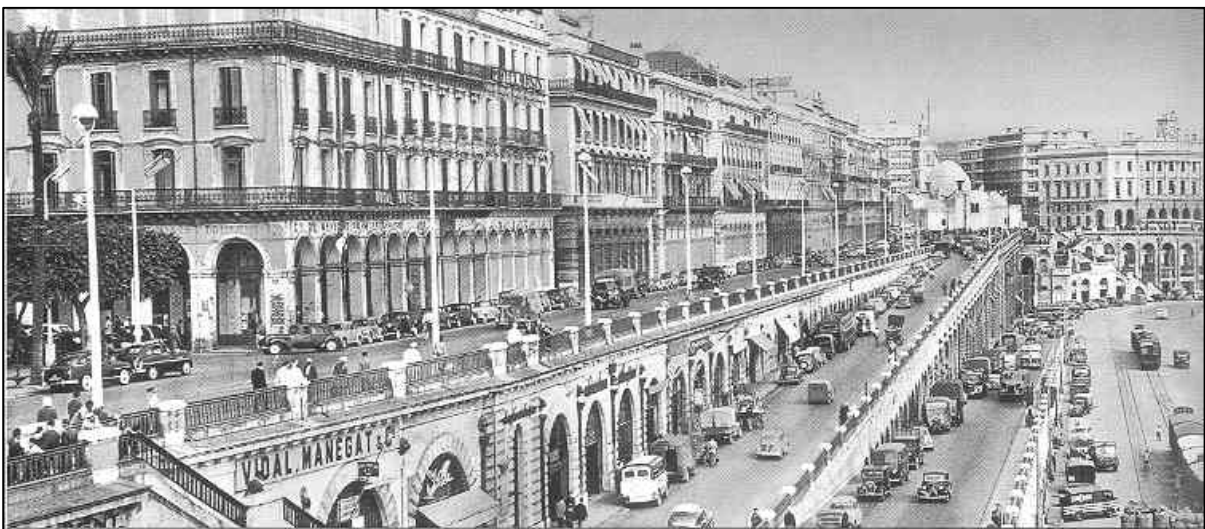
Figure 70: Boulevard de la République avec ses rampes et ses escaliers construits sur des voûtes étagées de 1860 à 1866. Source : http://algeroisementvotre.free.fr/site1000/alger09/alger040.html . 2009
