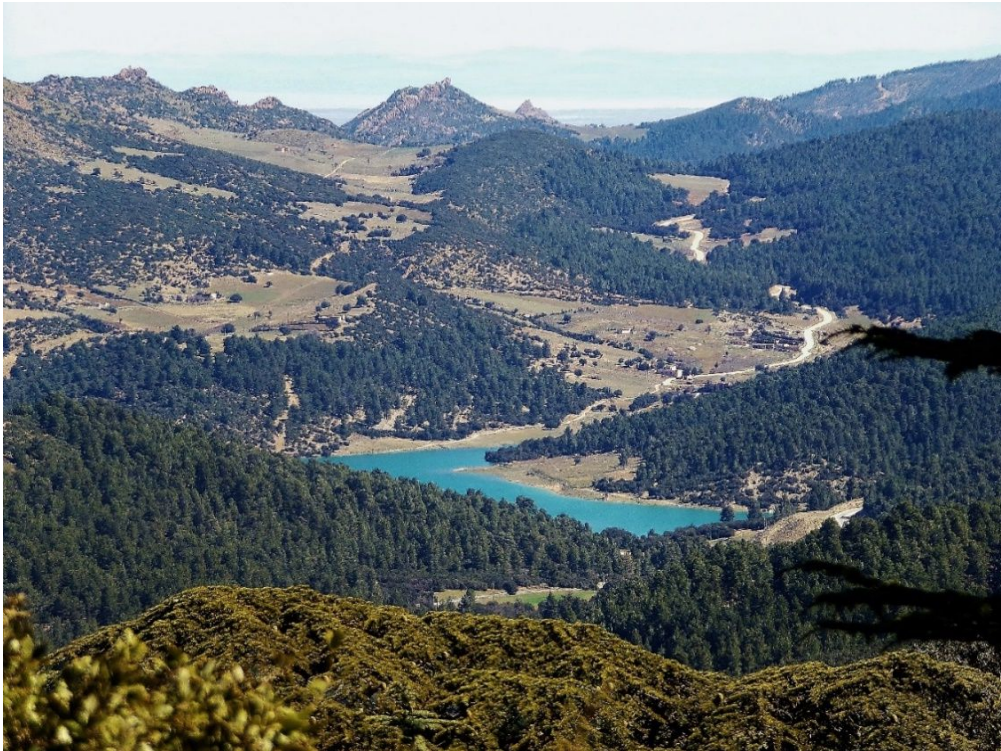
Figure II.27 - Vue générale du barrage de Tagharist (mars 2019) (Facteur I).
