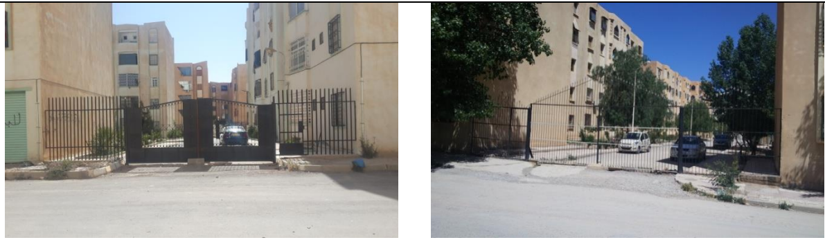
Photo 14 : Des accès mécaniques condamnés
