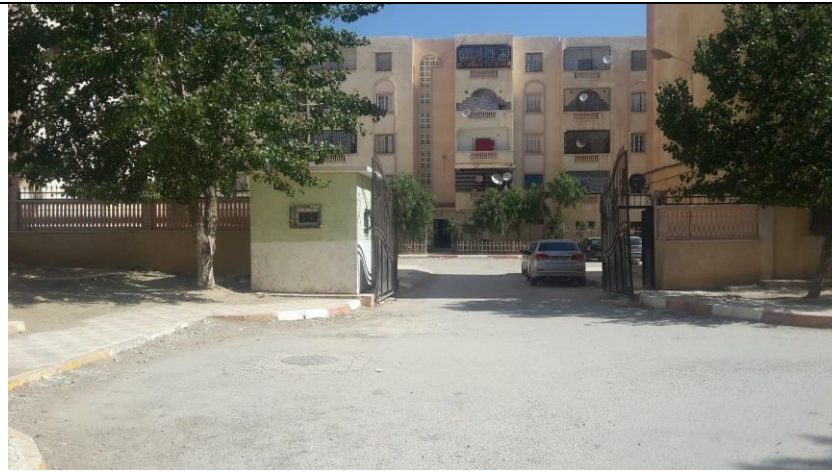
Photo 12 : Clôture en maçonnerie avec claustras
