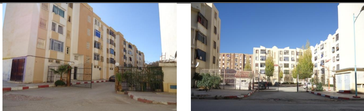
Photo 13 : Les accès mécaniques et piétons
