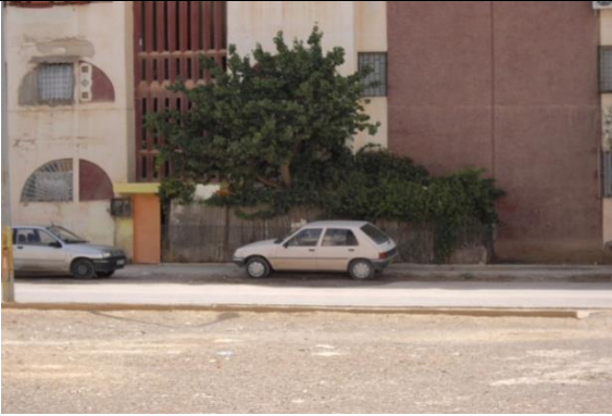
Photo 14 : Une clôture en roseaux entoure l'espace extérieur attenant au logement
