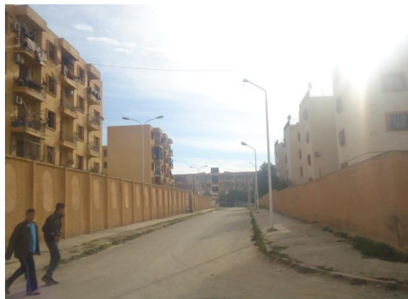
Photo 23 : Habitat collectif du type social, la clôture a été construite ou renforcée par les habitants de la cité
