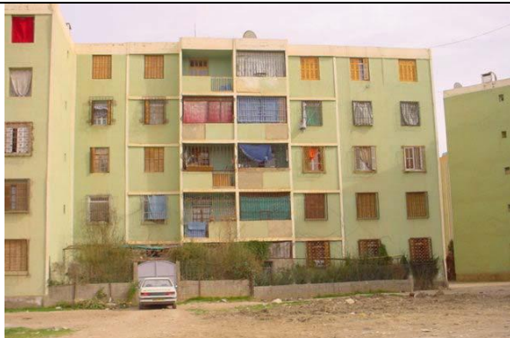
Photo 39 : Transformation de l'espace limitrophe en abri couvert intégré à l'espace extérieur clôturé
