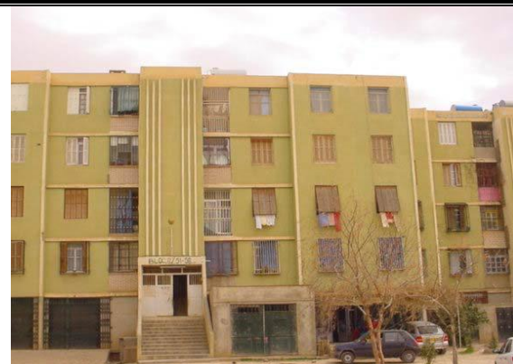
Photo 40 : Transformation de l'espace limitrophe en garage construit pour stationnement
