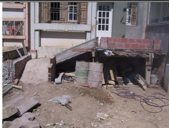
Photo 27 : Rajout d'une volée d'escaliers
