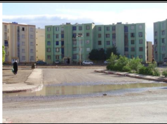
Photo 7 : Stagnation des eaux ménagères déversées à l'extérieur
